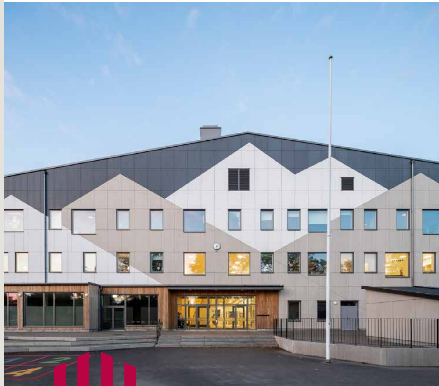
Långsjöskolan utanför Stockholm. Arkitekter Arkitema och i tidigt skede Tyréns. Produkter: Swisspearl Patina Inline och vindskyddet Windstopper bakom, tidigare Cembrit. Foto: Johan Eldroth
